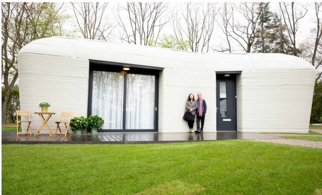
FIGURE 19 – Maison imprimée en 3D - en seulement 120 heures
